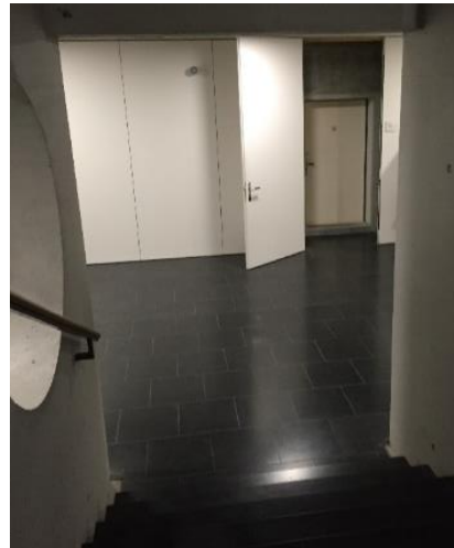
Abb. 19: Treppe im Schulhaus St. Gallen
