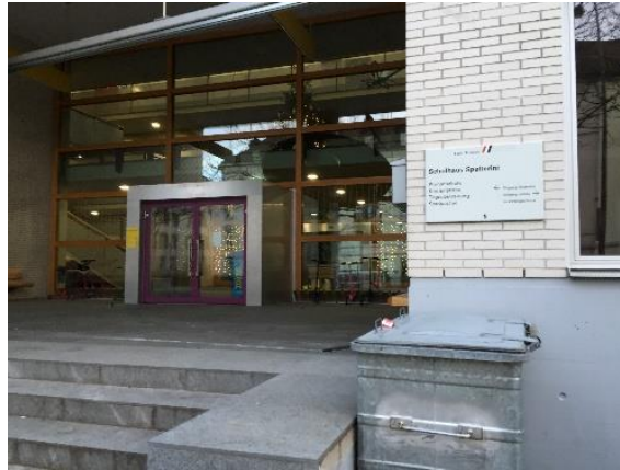
Abb. 17: Eingang des Schulhauses, St. Gallen
