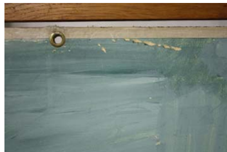
Detail: Öse im linken oberen Eckbereich für die Aufhängung; Verletzungen der Malschicht
