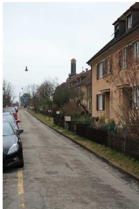
„Birbaumallée“ mit Blick nach Südwesten in Richtung Spielwiese.
