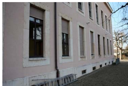
Aussenansicht des neuen Aufbewahrungsraumes (vier Fenster im Vordergrund). Über den Fenstern sind die in der Nacht mit Bewegungsmeldern angesteuerten Lampen sichtbar.
