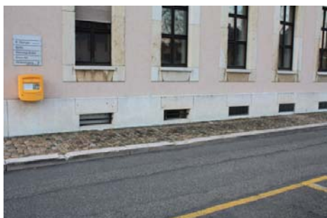
Die Fensteröffnungen des Archivraumes im Kellergeschoss von aussen gesehen.
