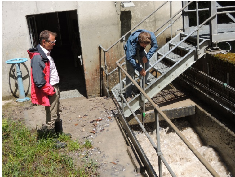
Abbildung 37: Probenahme im Oberwasser des Coanda-Rechens an der Samina, Frastanz (AT) beim ca. 10-jährlichen geschiebeführenden Hochwasser vom 17.6.2016
