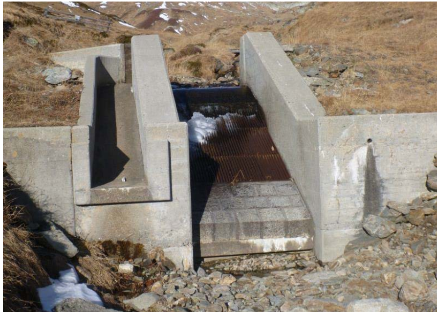
Abbildung 8: Beispiel eines Tirolerwehrs am Oberalppass (GR) Quelle: unbekannt
