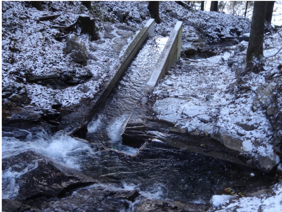
Abbildung 31: Leitkanal für eine gleichmässige Anströmung im sehr steilen Bachgerinne Mühlbach, EW Azmoos, Oberschan SG
