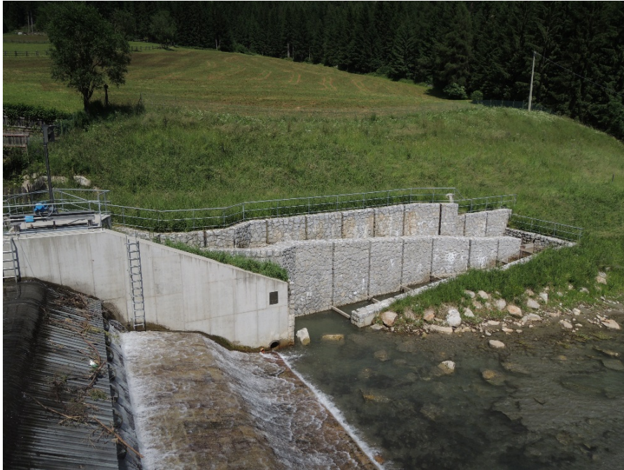
Abbildung 35: Vertical Slot Fischpass, das Unterwasser ist für den Fischabstieg nicht ideal gelöst, Vallerbach, Vals (I)
