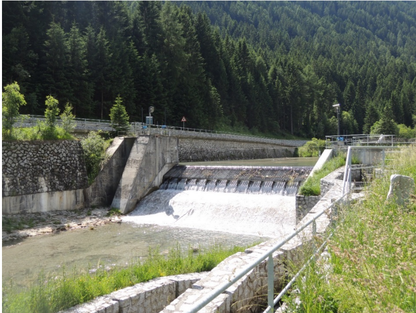
Abbildung 9: Fassung am Vallerbach bei Vals, Südtirol
