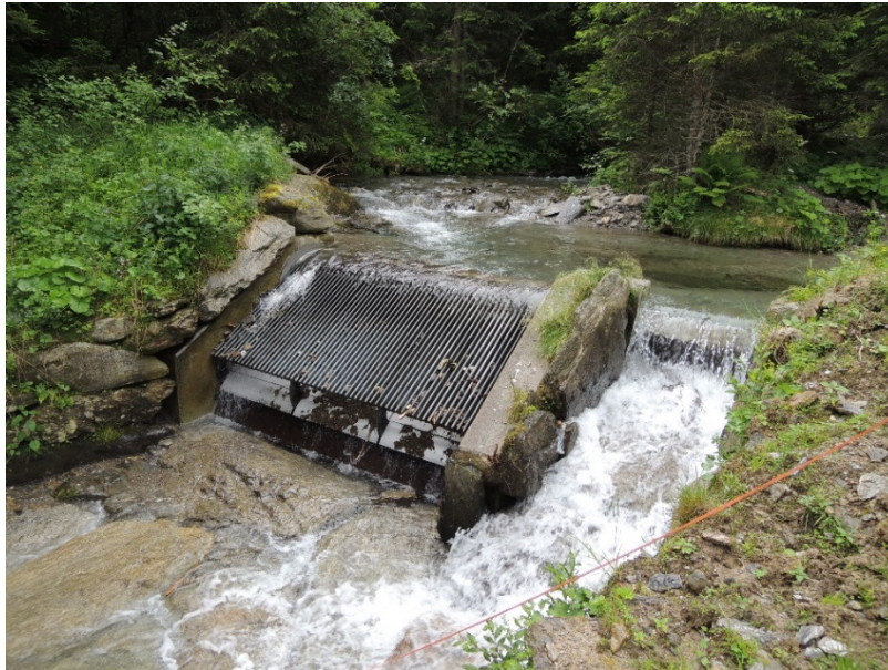
Abbildung 32: Geschleib- schutzrechen, Fabrikat: Wild Metal GmbH, Typ Grizzly Val- tigelbach, Ratschings (I)
