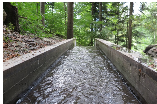
Abbildung 21: Zulauf Coanda-Rechen
