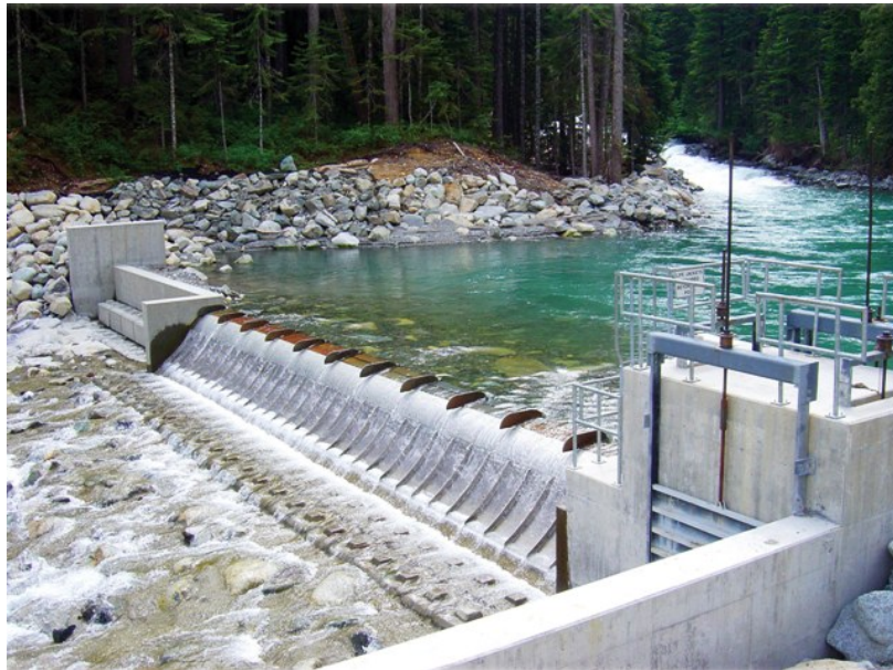
Abbildung 11: Grosse Wasserfassung mit einem Coanda-Rechen in Kanada
