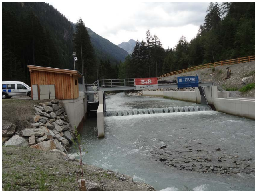
Abbildung 6: Aktuell europaweit grösster Coanda-Rechen bei St. Leonhard am Pitzbach (Tirol).
