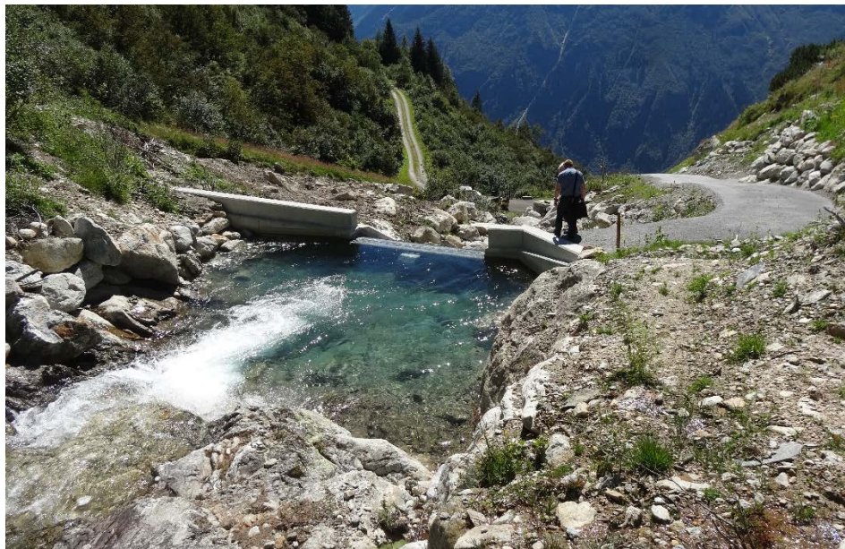
Abbildung 30: Leichter Gewässer- stau im Ober- wasser zwecks gleichmässiger An- strömung und Ge- schieberückhalt, Hostetbach, Gut- tannen BE
