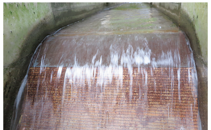
Nahaufnahme eines Coanda-Rechens: Die horizontalen Metallstäbe wirken wie Rasierklingen, die das Wasser schichtenweise abscheren. Foto: HTW Chur
