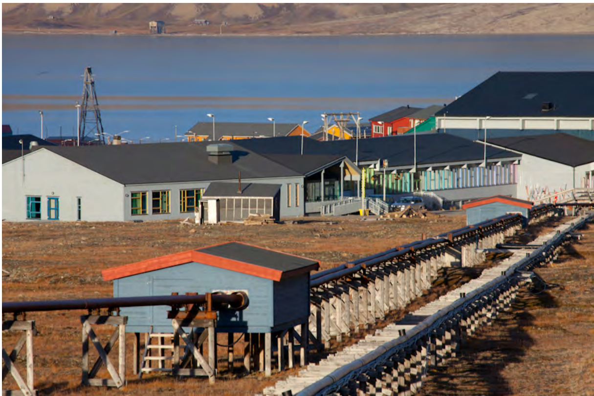
Figure/Abbildung 13: Adventfjorden and part of Longyearbyen, showing the transportation pipes of hot water (from coal plant) for heating the houses. Adventfjorden und ein Teil von Longyearbyen mit den Transportrohren für heisses Wasser (vom Kohlekraftwerk), um die Gebäude zu heizen.
