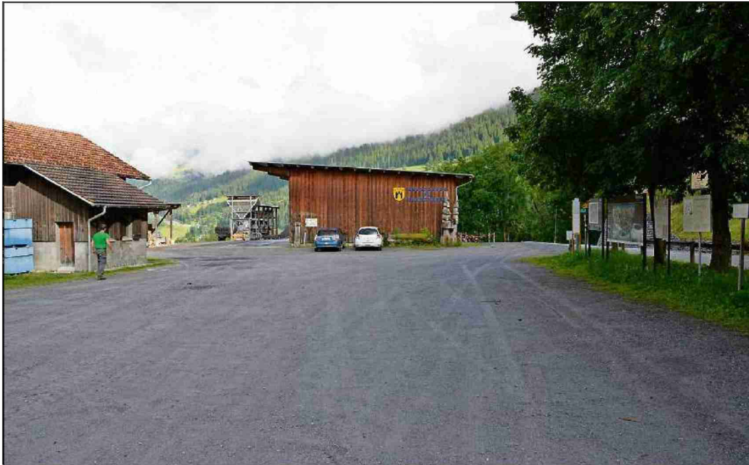
Im Parclis in Trin möchte man einen neuen Forstwerkhof errichten, die Entscheidung für einen Projektionskredit wurde allerdings vertagt. Bild sj
