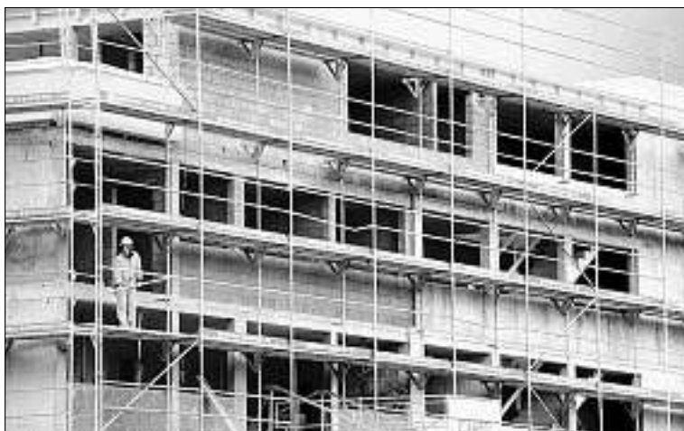
Baustelle in Chur: Die höchsten Arbeitslosenzahlen verzeichnet derzeit das Baugewerbe. (Foto Marco Hartmann)
