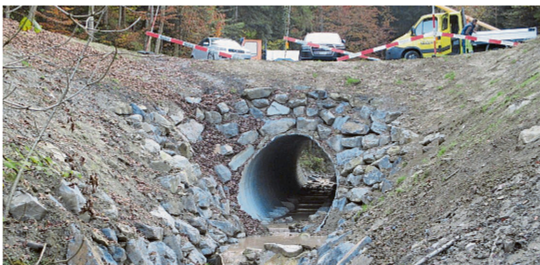
Mehr Platz für den Klusbach: Die Sanierungsarbeiten am tiefsten Punkt der Sonderstrasse sind weitgehend abgeschlossen. Bild: PE
