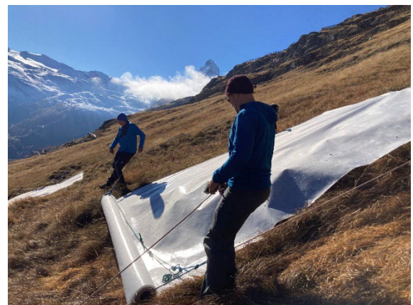
Abbildung 2: Installation der Geotextil Folien im Gelände (©James Glover, FH Graubünden)
