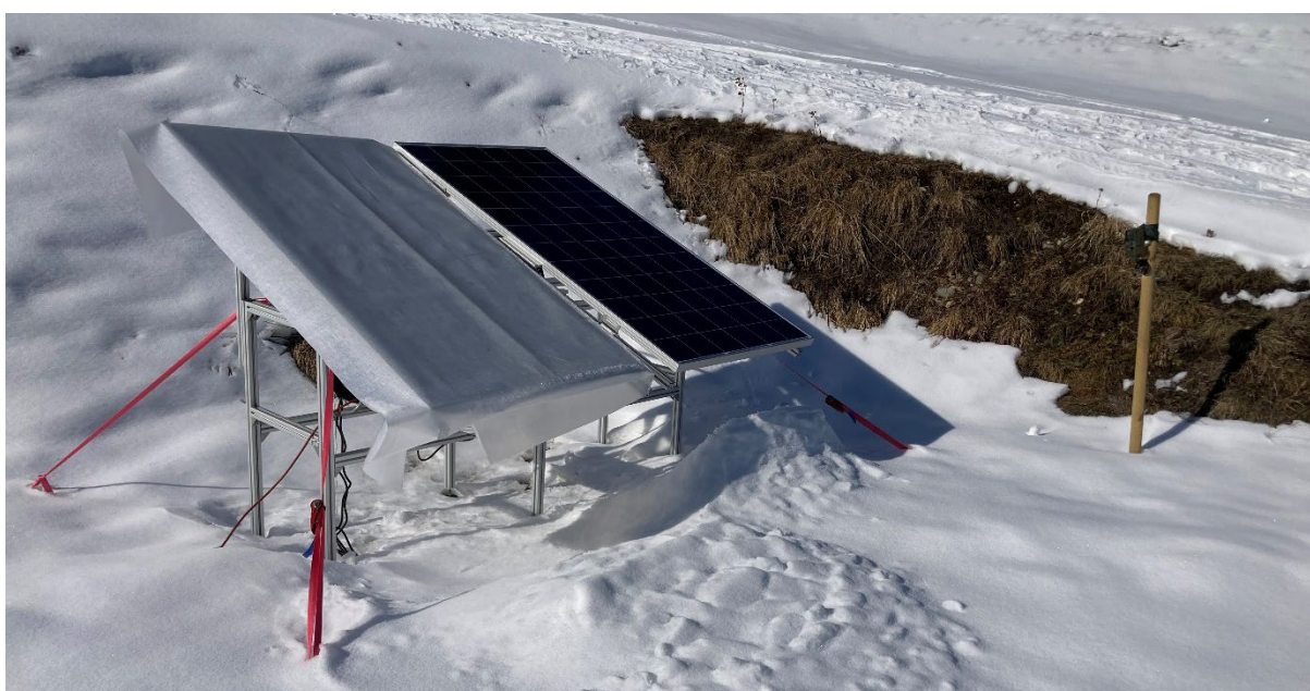
Abbildung 7: Geotextilfolien werden verwendet, um den Schnee von Solaranlagen zu räumen. In diesem Experiment wird der Vergleich der Solarproduktion mit und ohne Geotextilien getestet.
