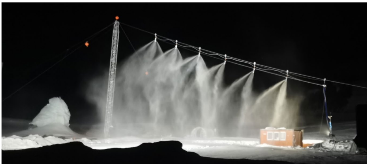
Abbildung 9: Abbildung: Betrieb der Testanlage Diavolezza bei Nacht
