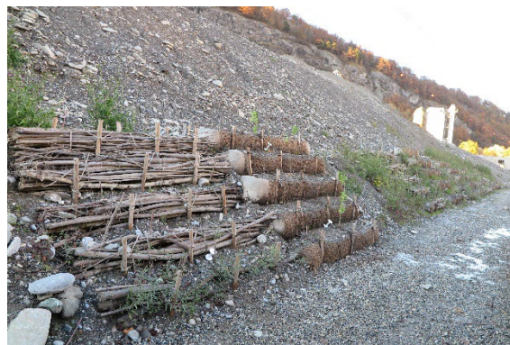
Abbildung 8: Installation von Holzwolle-Faschinen in Chur
