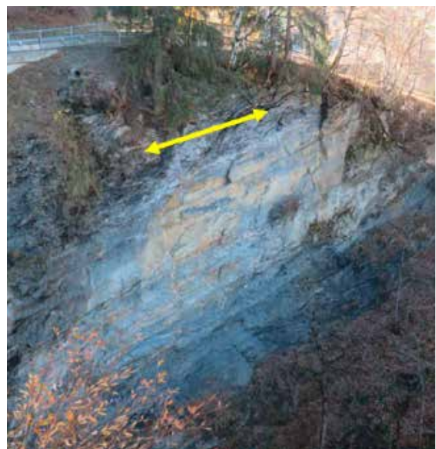
Felswand Seite Vals mit Lage des Widerlagers
