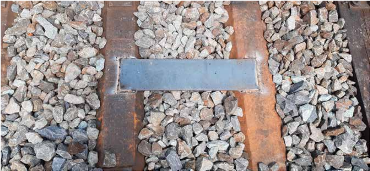
Verschweissen der Stahlschwellen mit Stahlplatten
