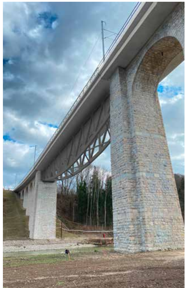
Visualisierung des Tragwerks unterwasserseitig nach Osten
