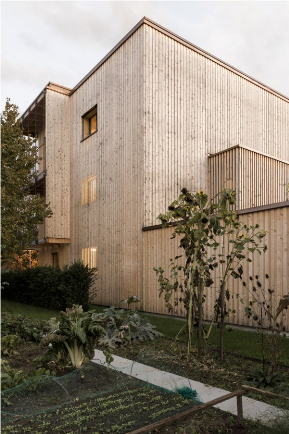
Generationen-MFH, Weinfelden/TG, Schweizer Solarpreis 2019, Bauatelier Metzler GmbH
